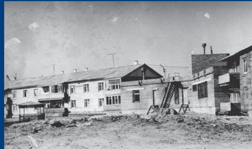
Строительство почтового отделения
