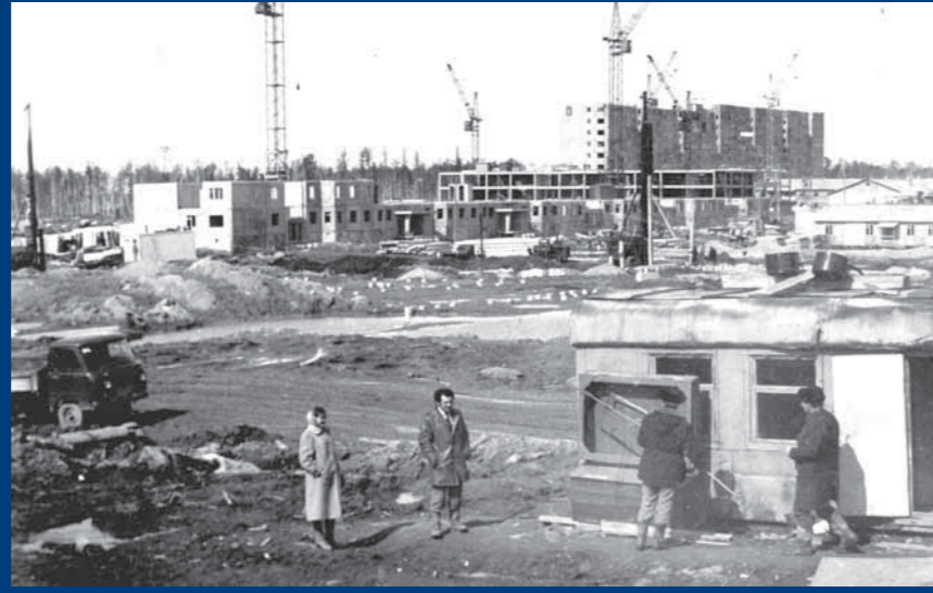
Строительство первой школы
