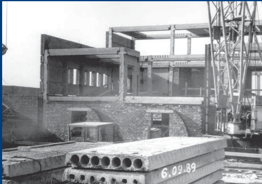
Лангепас. Строительство торгового центра
