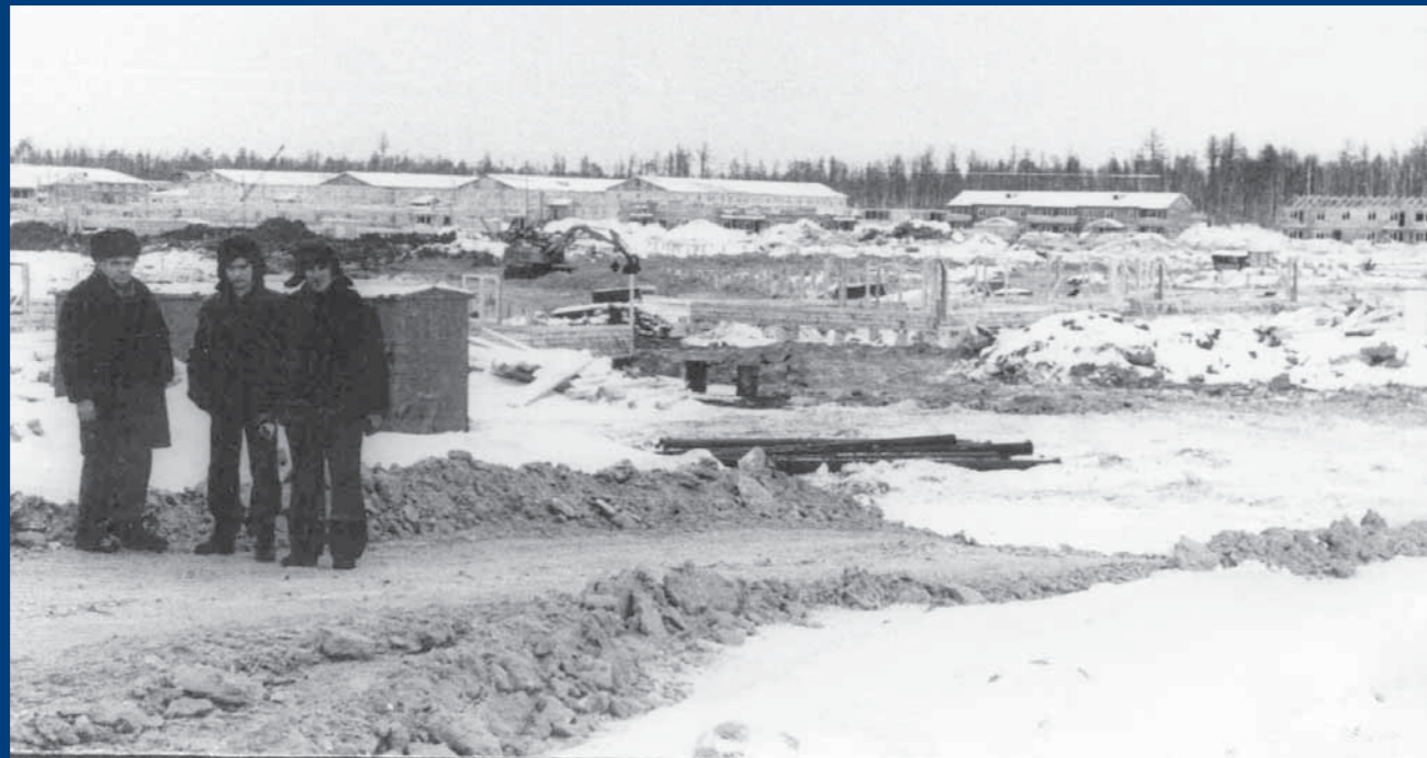
Строительство поселка Лангепас
