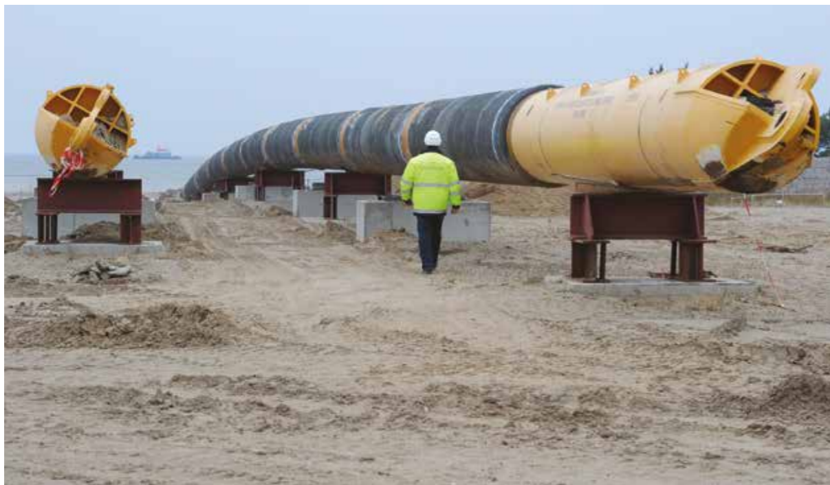
Газопровод «Северный поток-1»
