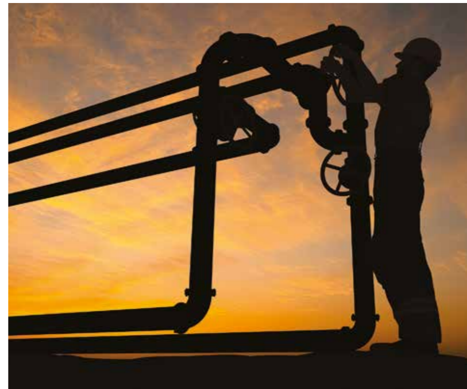
Отладка клапана межпоселкового газопровода Источник: Iurii / Depositphotos.com
